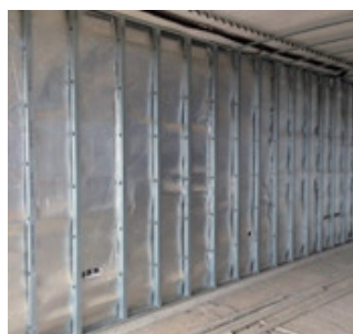
Paredes y cerramientos
