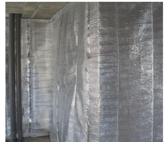
\*Combinación realizada entre aislante Air-bur Termic y un aislante de masa (lana mineral, XPS, EPS... de conductividad térmica 0,036 W/mk).
